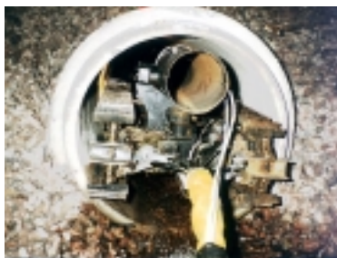
Rensning i kulvert Ø 600 mm.
